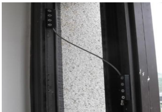
图 2.3-1b 平开扇防脱落示意照片
