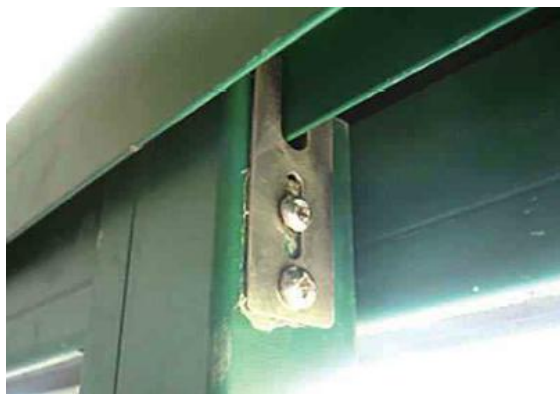
图 2.3-1c 推拉扇防脱落装置片示意照片
