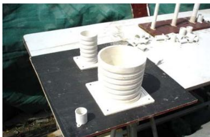
图 2.12-1b 止水节现场照片
