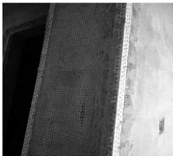
图 2.8-2 转角处、墙面粘结塑料护角及网格布参考做法
